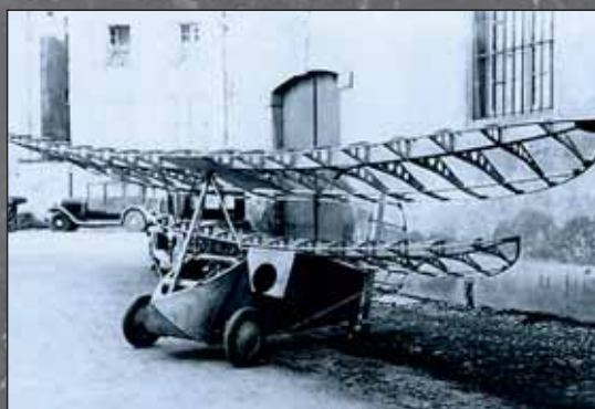
Ossature d'un pou
