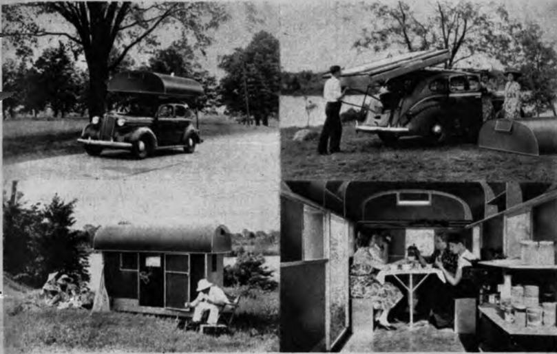
Avec ses six fenêtres équipées de vitres en verre et de stores permanents, cette maison préfabriquée démontable nouvellement développée peut être transportée sur le toit d'une voiture ordinaire. Elle permet ainsi aux sportifs, pêcheurs et amateurs de plein-air de profiter de séjours courts ou prolongés, dans un total confort. Dans sa forme compacte, la maison pliante mesure seulement 1,83 m de large, et 2,75 m de long pour
